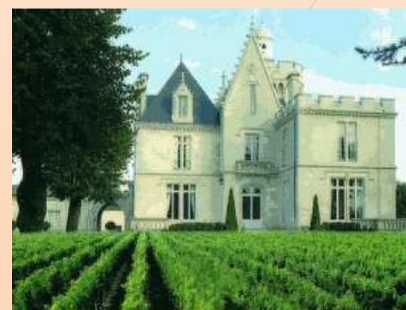
Construction du château Pape Clément actuel
