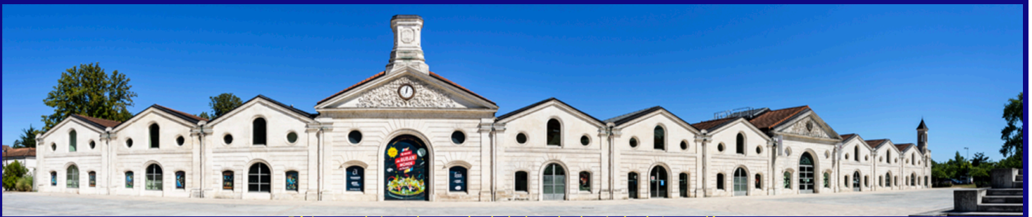
Bâtiment abritant le musée de la bande dessinée, à Angoulême
