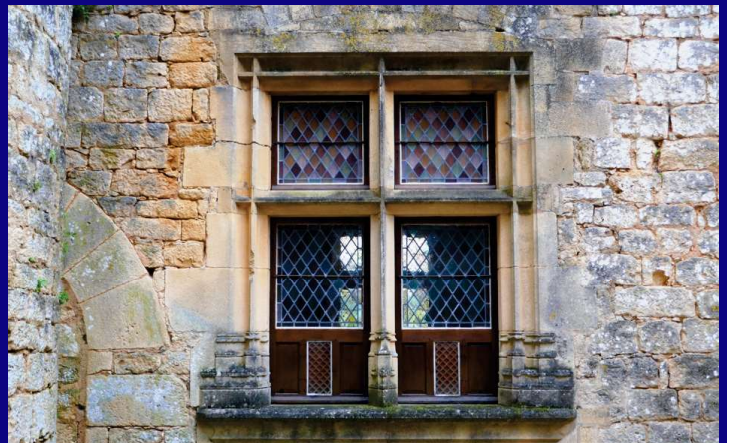
Fenêtre renaissance, signe de modernisation du château
