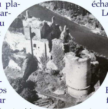
Le château avant restauration
