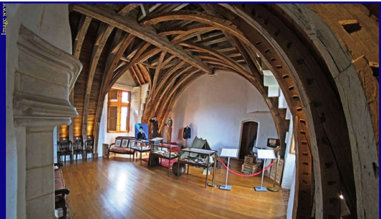
Salle "Résistance" et sa superbe charpente en chêne
